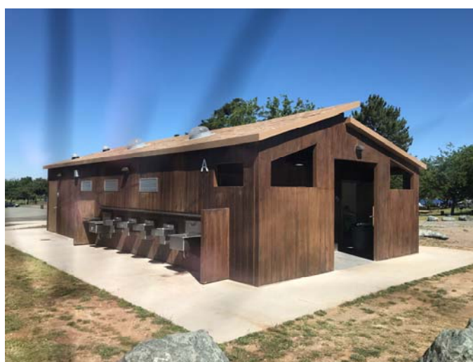
Nhà Vệ Sinh- Nhà Tắm - Bathrooms
